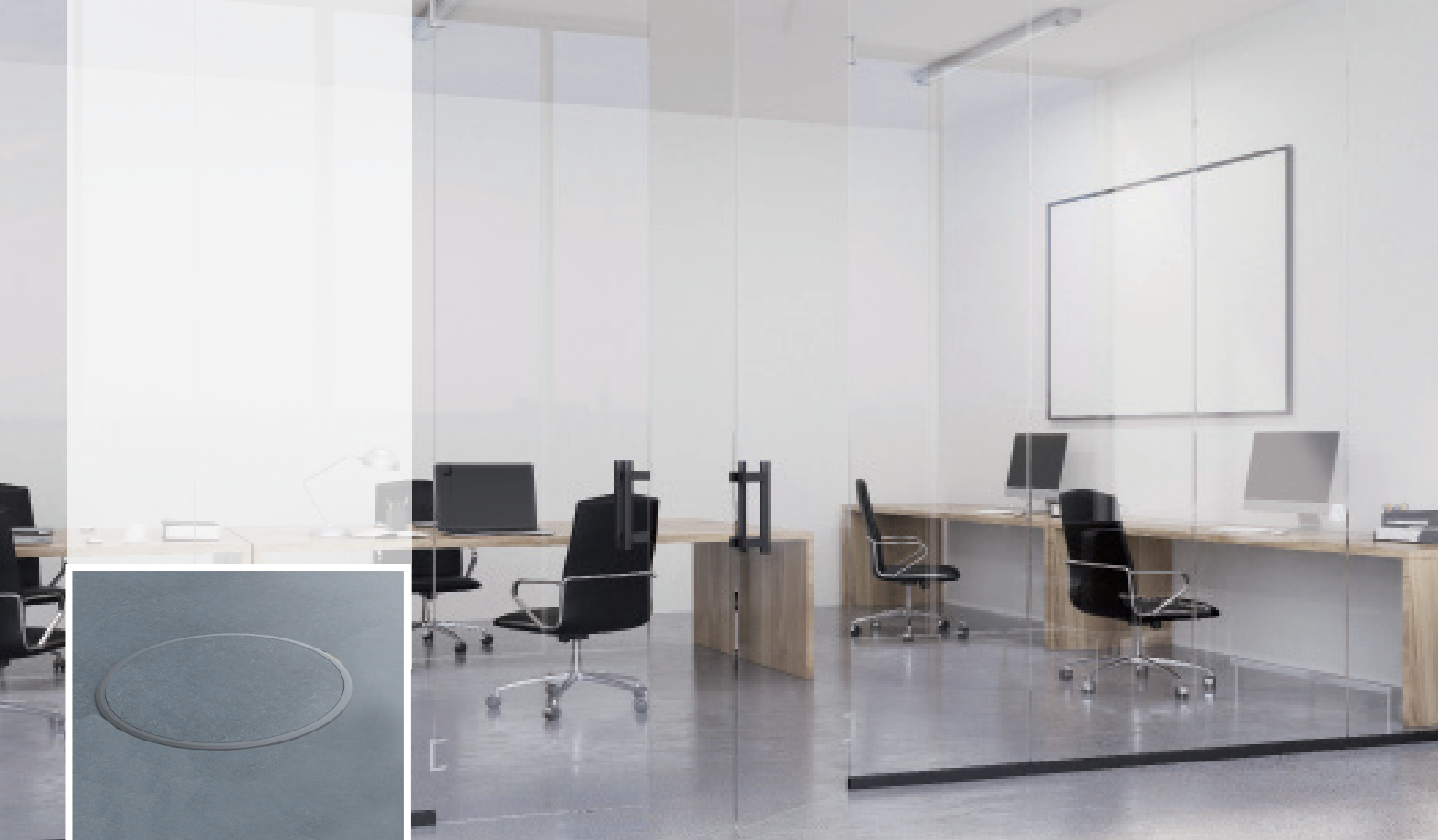
VERZONKEN VLOER, NIET WATERDICHT
